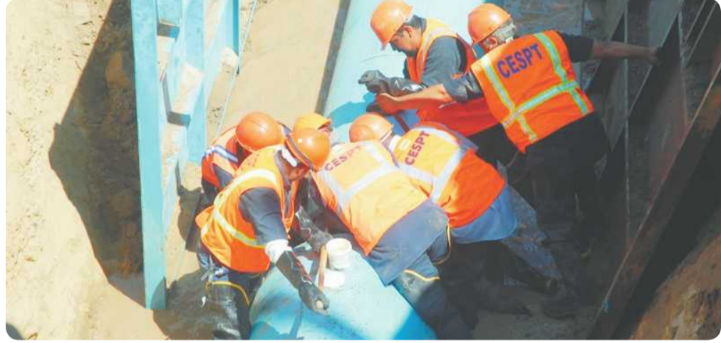
TIJUANA.- La CESPT controló una fuga de agua en Playas de Tijuana.
