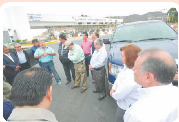
ENSENADA.- Raúl Carrillo, dirigente del transporte, hizo planteamientos previos sobre las dudas a despejar en este recorrido en el que se constató el avance de obras.
