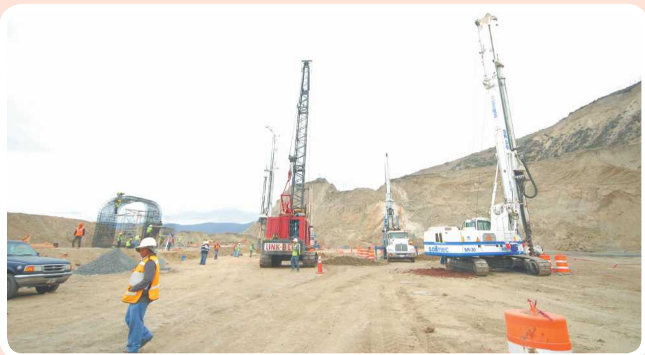
ENSENADA.- En la zona de trabajo las medidas de seguridad son extremas para evitar accidentes, dado que se maneja maquinaria pesada y se mueven cargas descomunales.
