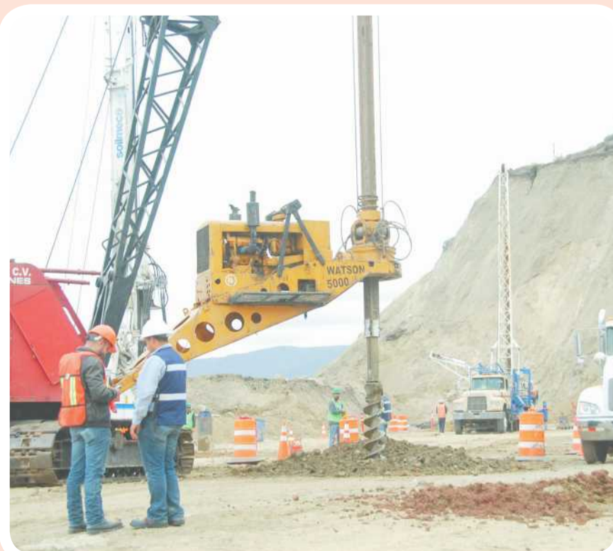
ENSENADA.- Diversa maquinaria pesada es utilizada para trabajos específicos en la zona del desplome de la autopista y continuará los trabajos luego del reinicio de la circulación vehicular.
