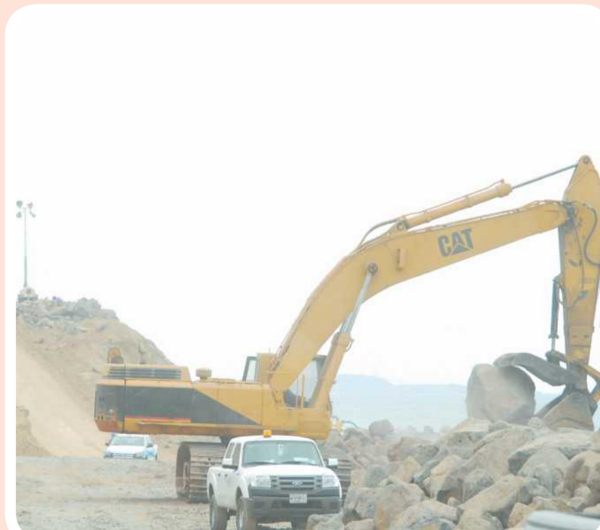
ENSENADA.- La zona de playa será reforzada con piedra para hacer un contrapeso que contribuirá a evitar el deslizamiento del suelo.
