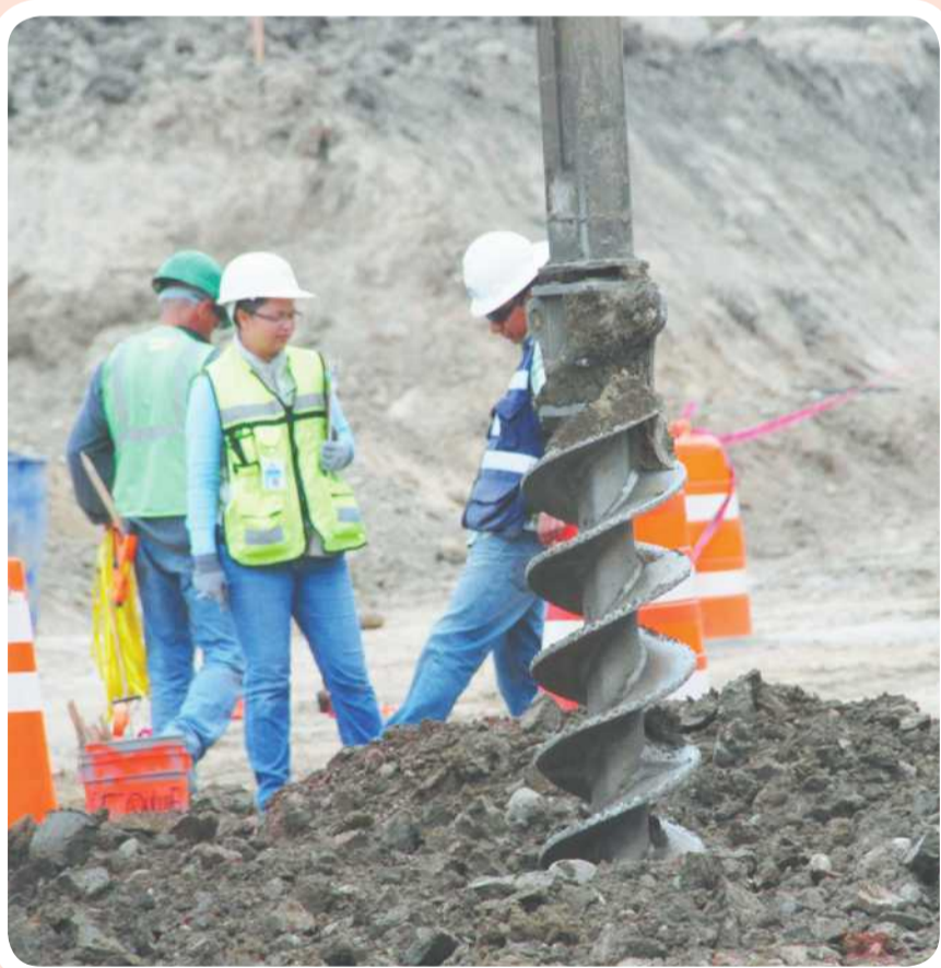
ENSENADA.- La parte medular en la reparación del tramo colapsado de la autopista es la terminación de pilotes que darán la estabilidad al suelo.
