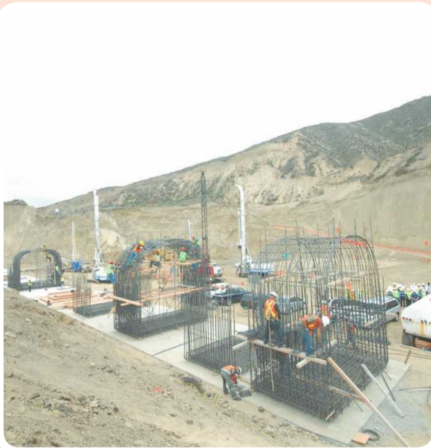
ENSENADA.- Estas estructuras prefabricadas son las que formarán el túnel o alcantarilla tipo bóveda para drenar el agua.
