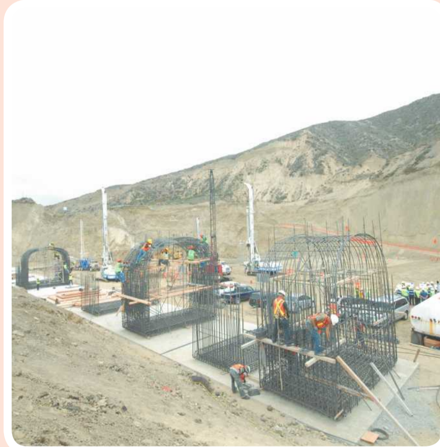
ENSENADA.- Estas estructuras prefabricadas son las que formarán el túnel o alcantarilla tipo bóveda para drenar el agua.
